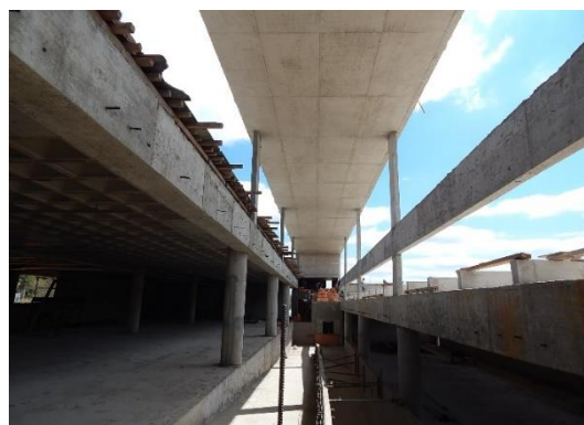
Solução construtiva racionalizada em concreto armado adotada no edifício da Biblioteca, Campus UFV-Florestal .
