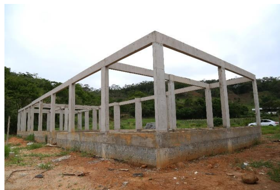
Instalações do Plantário, Campus UFV-Viçosa .
