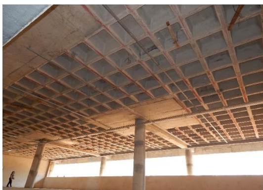
Solução construtiva racionalizada em concreto armado adotada no edifício da Biblioteca, Campus UFV-Florestal .
