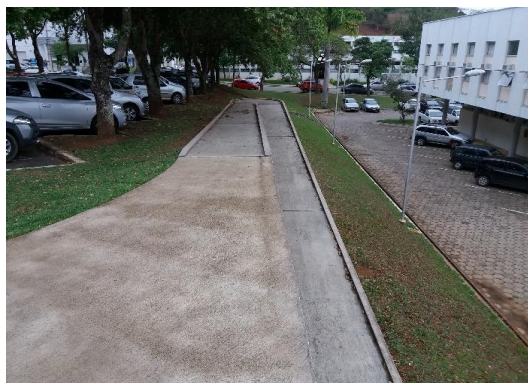
Rampas de acessibilidade, Campus UFV-Viçosa.
