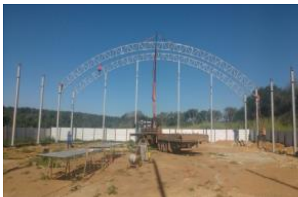
Cobertura metálica para quadra poliesportiva, Campus UFV-Florestal.
