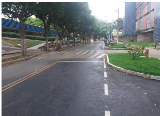
Passarelas para pedestres, Campus UFV-Viçosa .
