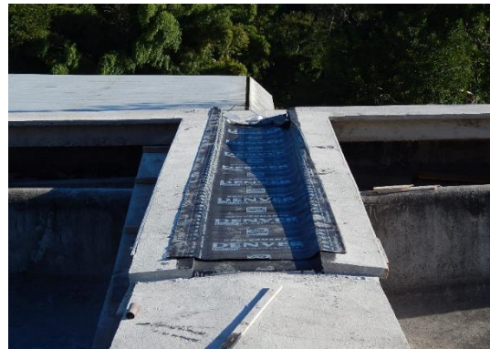
Reforma e impermeabilização da cobertura do Centro de Vivência, Campus UFV-Viçosa .
